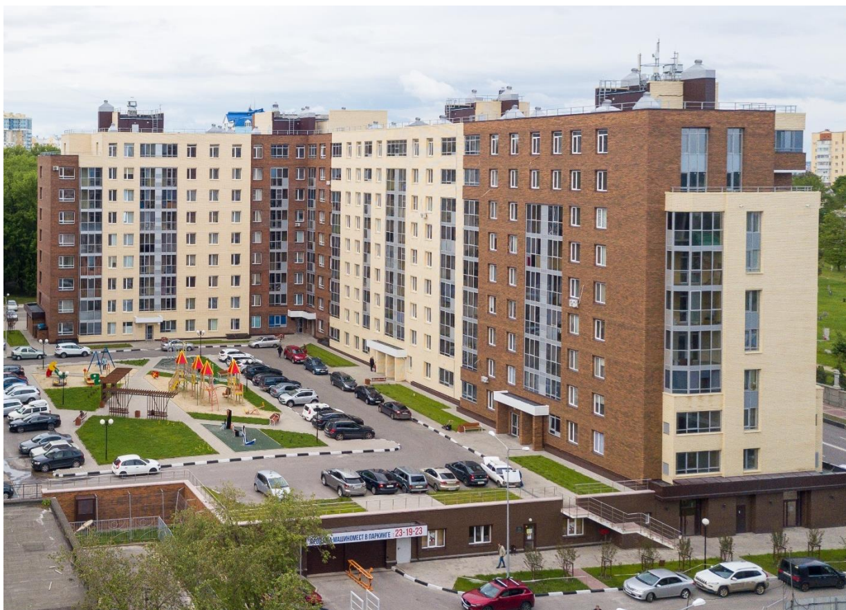
Рисунок 3.3 – Общий вид многоквартирного дома по ул. Попова (г. Белгород)
