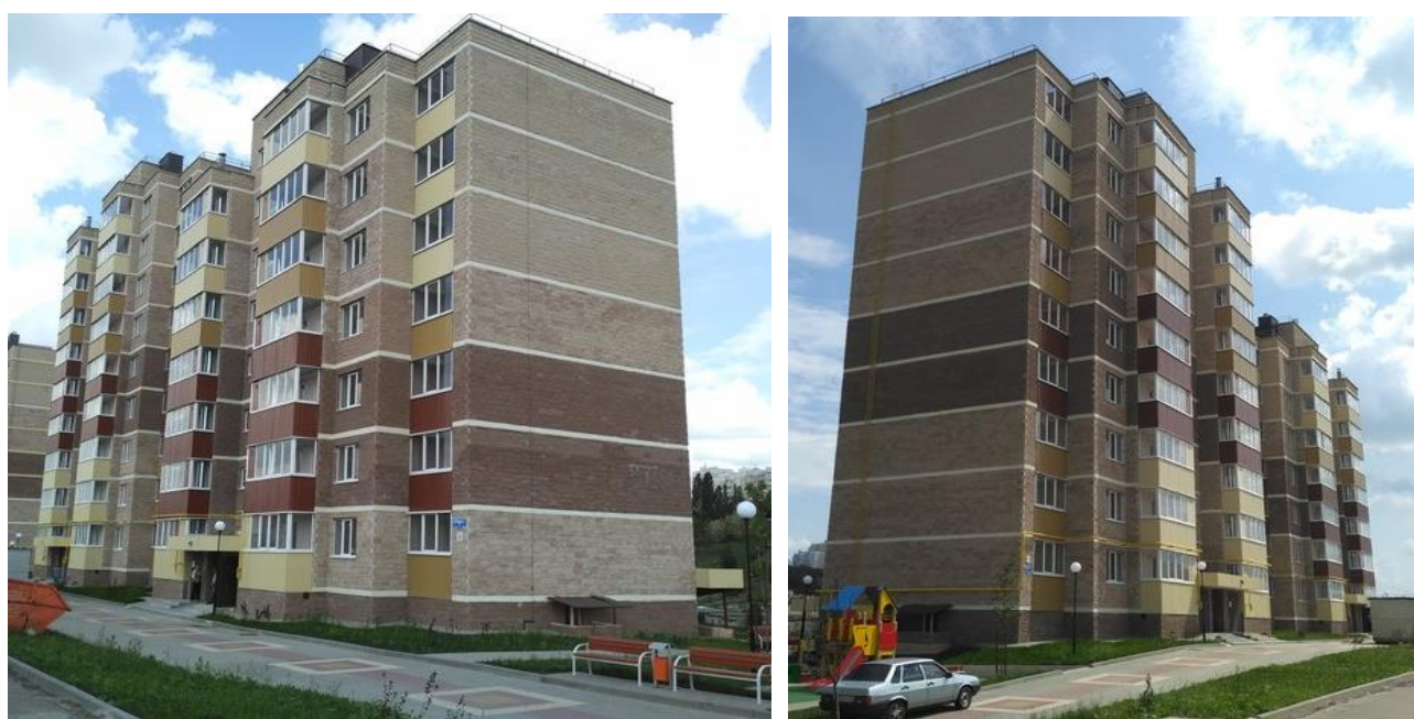
Рисунок 3.1 – Общий вид многоквартирного дома по ул. Квасова (г. Белгород)
