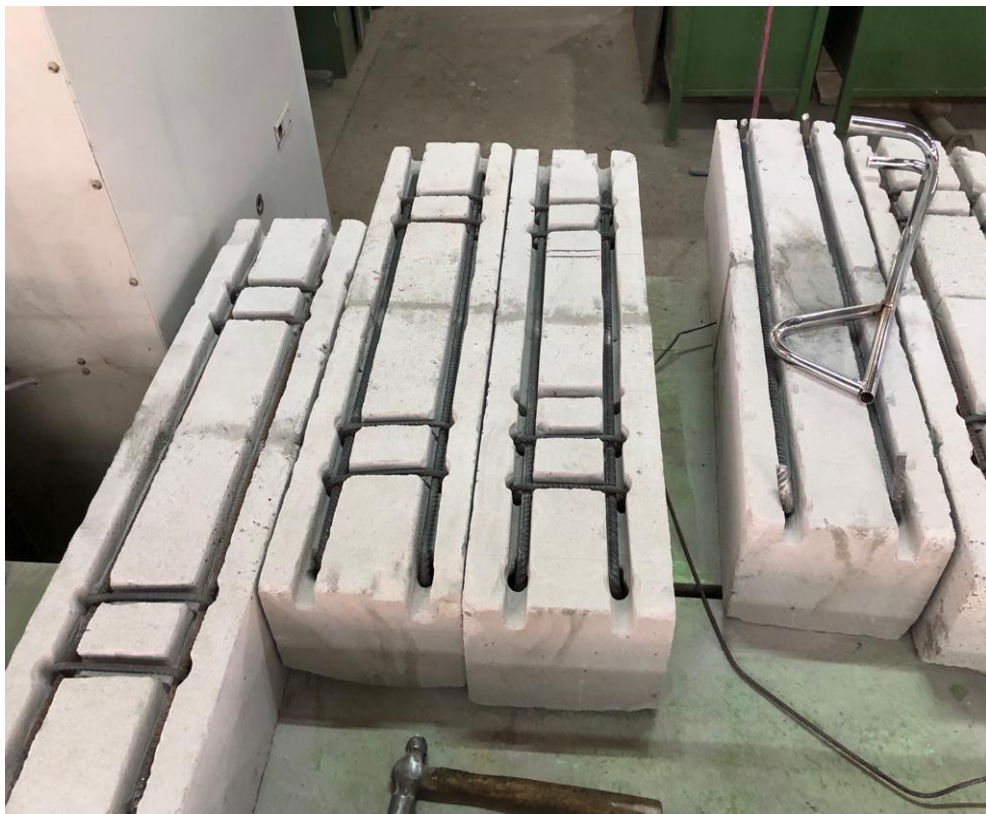
Рисунок 3.18 – Установка арматурного каркаса в газобетонных перемычках
